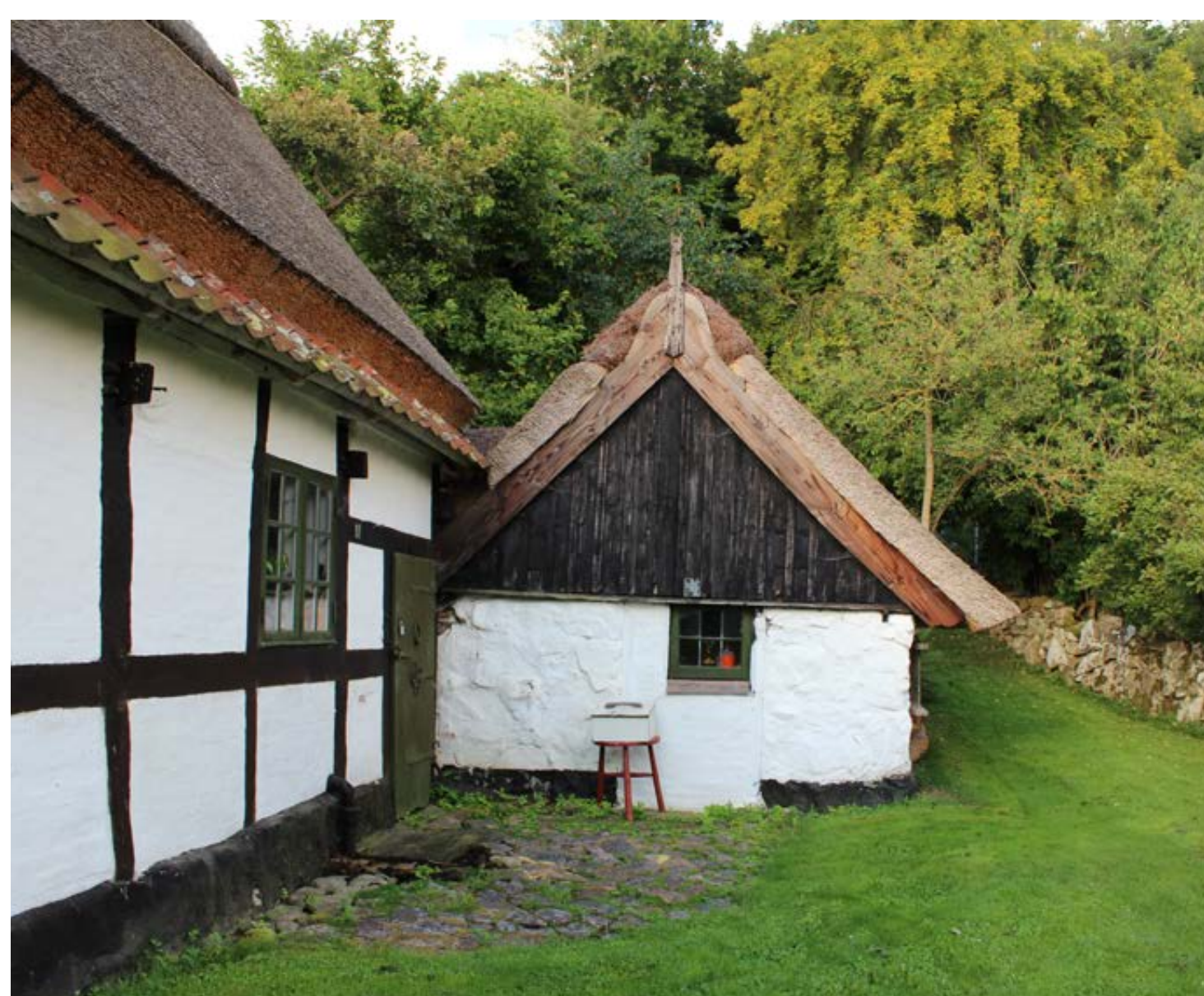
Bindingsværkshus med vinkelret afskåret strå og to rækker tagsten som tagskæg. Huset ligger på Bornholm, hvor vindskederne ofte samles og slutter i en såkaldt husbrand eller tordenstok, som det ses på sidehuset.
