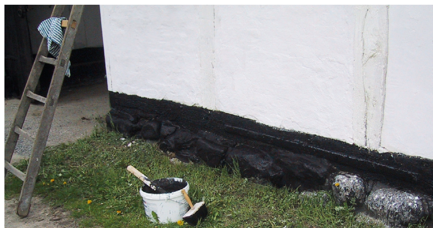
Tjæring af kampestenssokkel og fodrem med trætjære.
