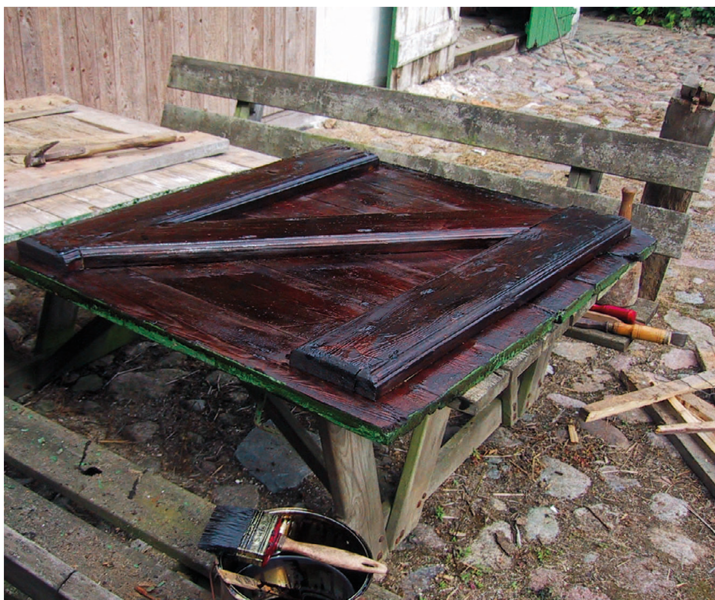
Regenerering af blødt og trasket træ på en 100 år gammel træluger. Træ tjæren erstatter de forsvundne olie-, harpiks- og tjærestoffer i træet, så træet igen bliver fast, hårdt og vandafvisende.
