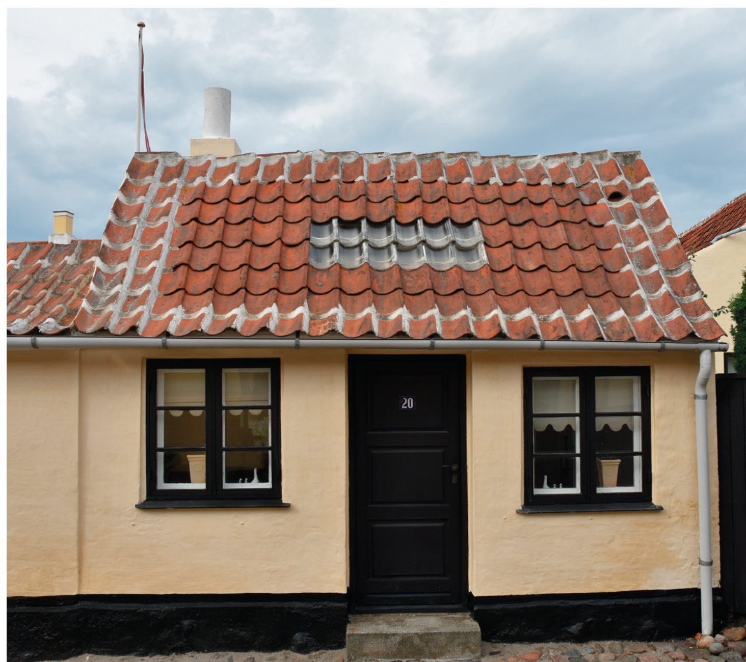
Hvor tagstenene er vanskeligt tilgængelige og derfor ikke kan understryges indefra, kan man i stedet forskelle, dvs. tætnes imellem tagstenene med mørtel udefra. Her er også forskellet langs opskalkningen, som er det lille svaj nederst på tagfladen lige over tagrenden.
