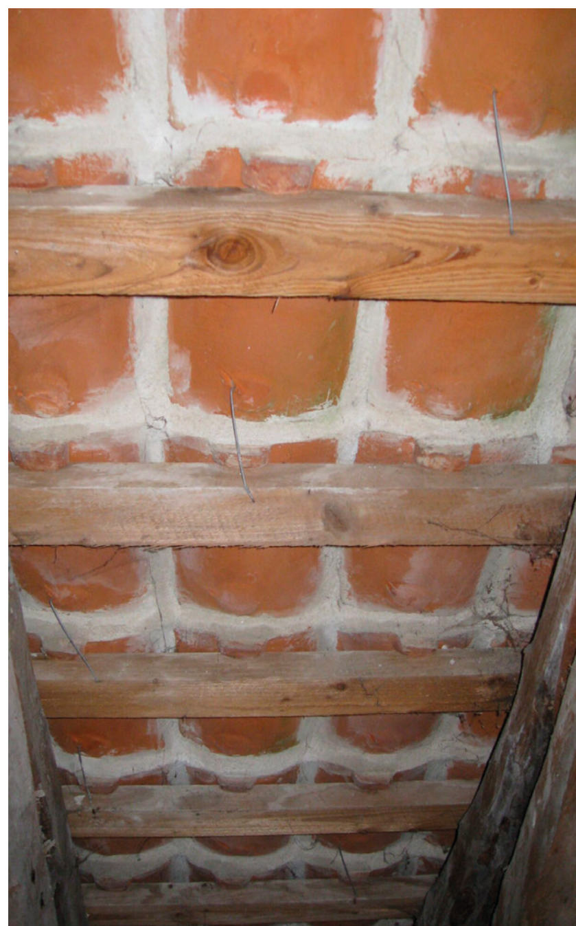
Understrykning af vingetagsten i uudnyttet tagetage er med til at sikre en tæt tagflade på et tag uden undertag.
