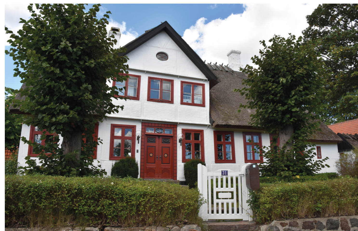
Støvlet Katrines hus i Bondebyen i Kongens Lyngby er fredet. Huset fremstår med en velbevaret klassicistisk facade mod gadesiden og er fint vedligeholdt med brug af traditionelle materialer.
