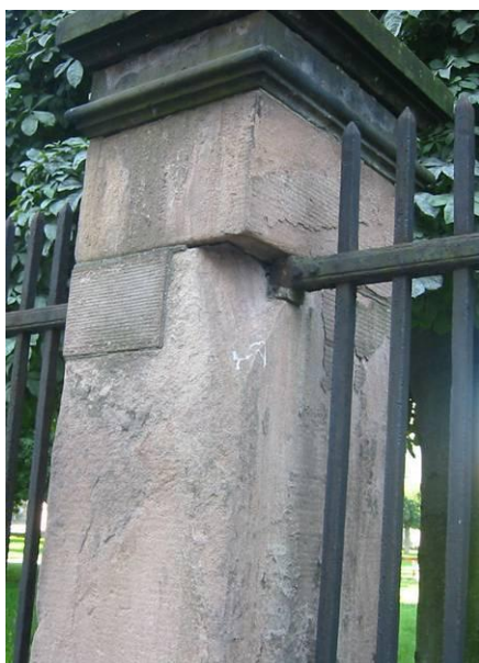
Fyring isat efter rustsprængt jern. Den modsatte side trænger også.
