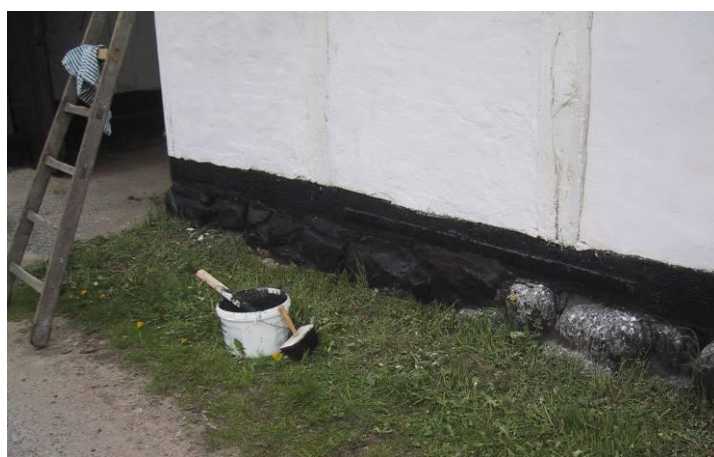
'Tjæring' af kampestenssokkel og fodrem med trætjærefarve.
