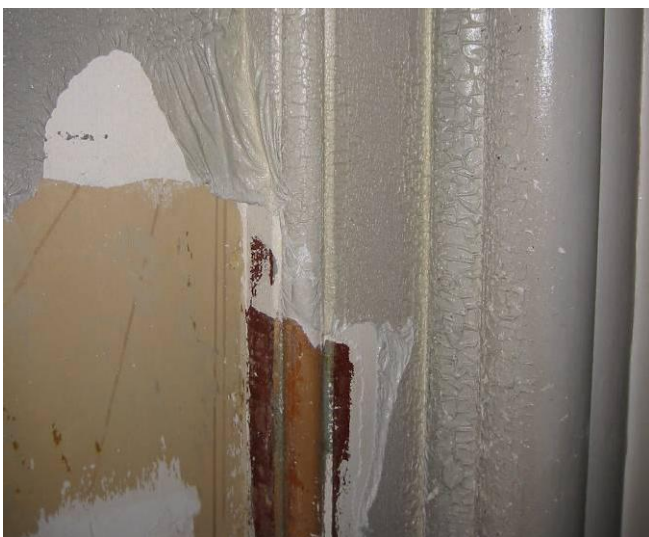
Aftagning af gammel plastikmaling
