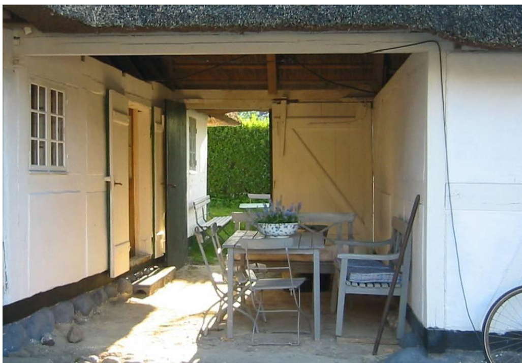
Portrum, hvor portenes bagsider er malet med kaseinfarve (kærnemælk, hjortetaksalt og kridt), mens væggene er kalkede med hvidtekalk
