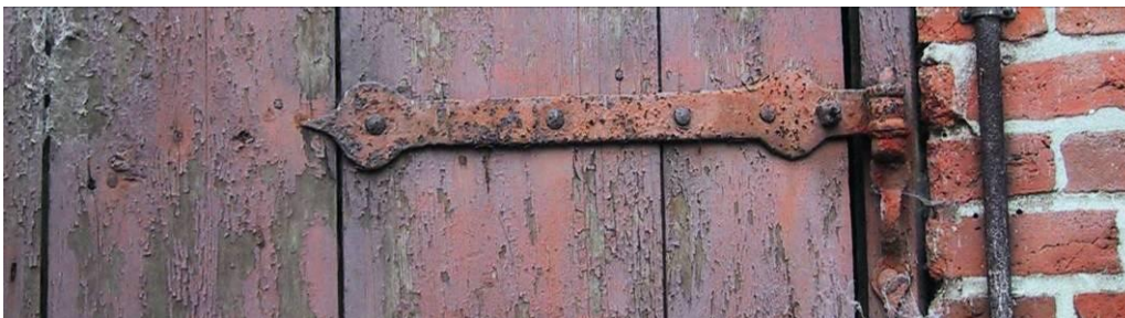
Fase 1: Let korrosion (rustpletter) grænsende til mellem korrosion (opboblede områder)
