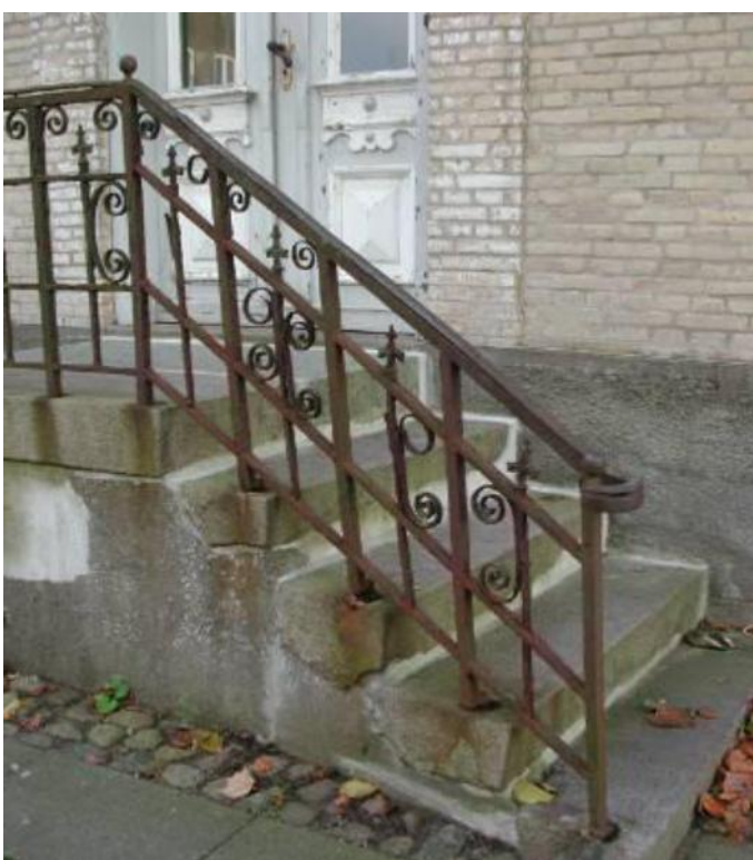
Fase 1: Let korrosion (rustpletter) grænsende til mellem korrosion (opboblede områder)
