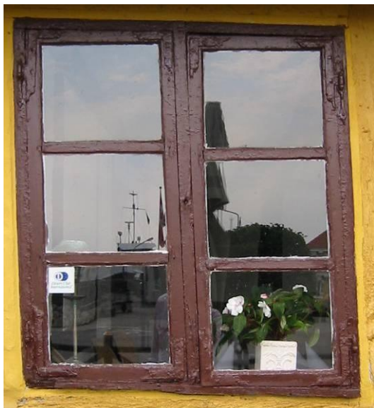
Ældre vindue forsynet med nyt floatglas
