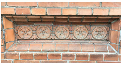
Eksempler på muret blænding.
