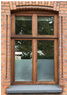
Eksempel på dannebrogs træ-vindue i original stil.
