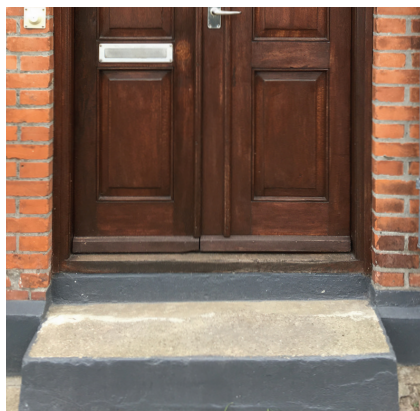
Trappesten, støbt i beton.
