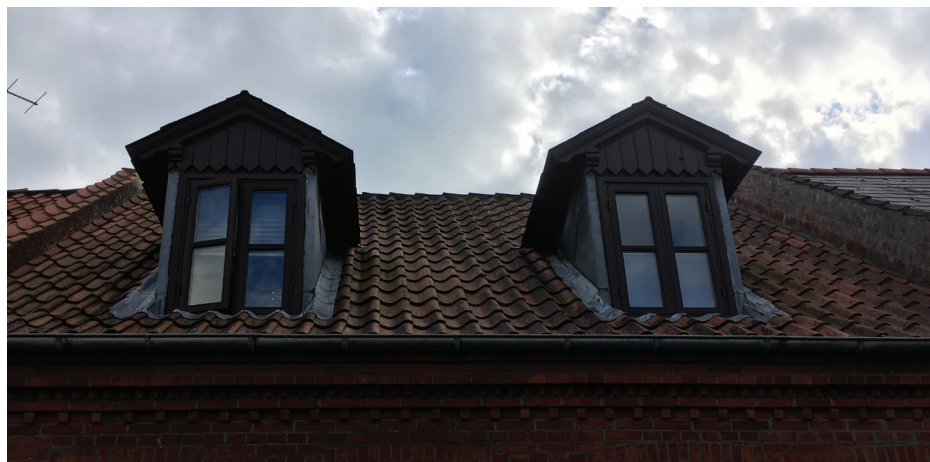
To heltagskviste med zinkbeklædning.
