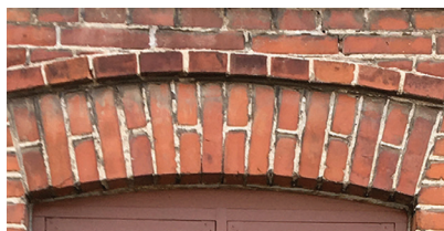
Eksempler på murede stik.
