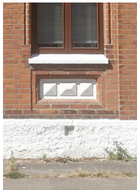
Muret sokkel med puds. og maling
