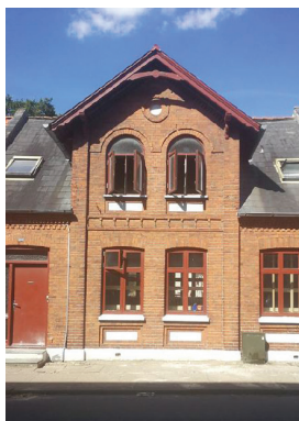
Gavlkvist med træbeklædning og detaljering.
