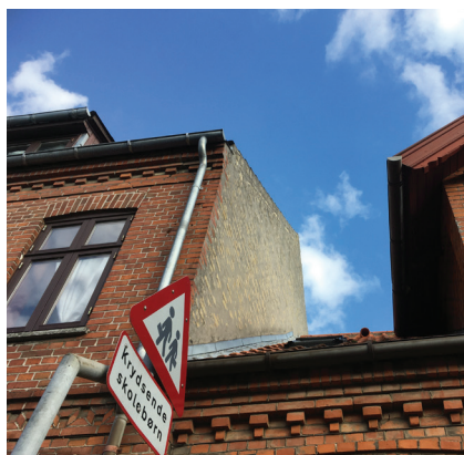
Nedløbsrør i zink.
