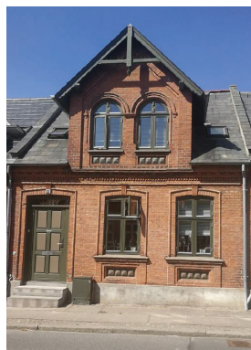
Gavlkvist med træbeklædning og detaljering.
