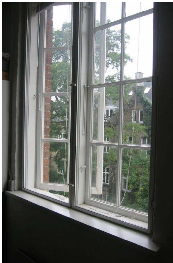
Indvendige forsatsvinduer – her spinkle rammer af aluminium har de mest effektive energiegenskaber ved opdelte vinduer – som her
