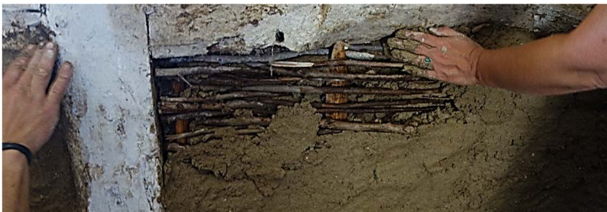
Lerklining af bindingsværk på hassel-kæppe
