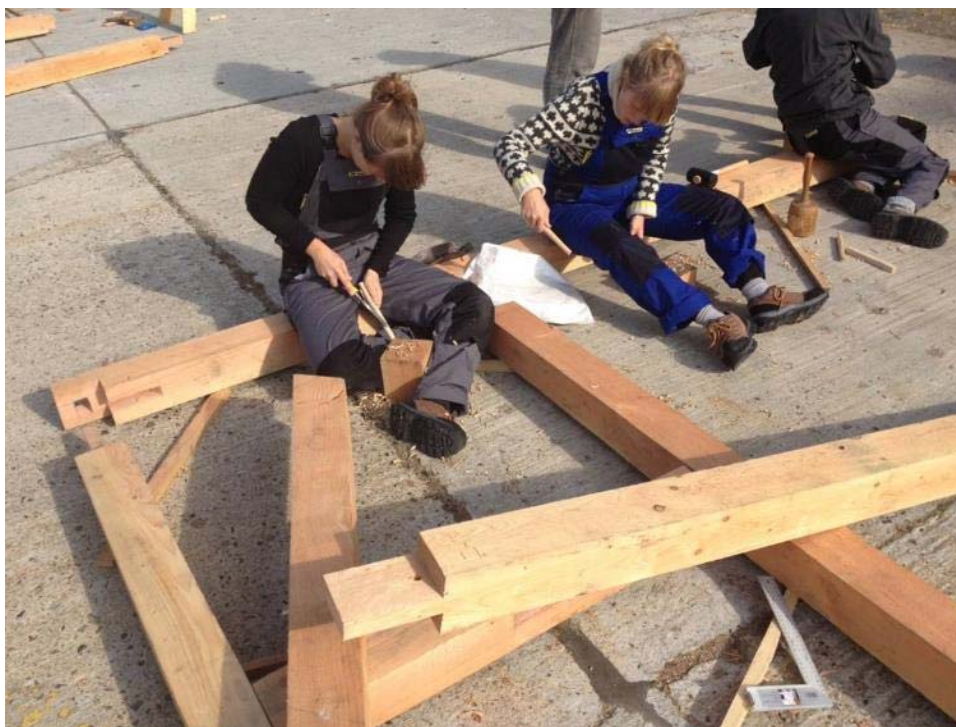
Tømmerkonstruktionen til en 'Haubarg', bygget af studerende på Arkitektskolen i 2012 som led i et forskningsprojekt på kandidatprogram i 'Kulturarv, Transformation og Restaurering'. Se også side 43.
