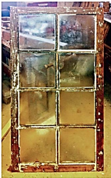
Vådafskrabning uden varme. Linolien blødgør og løsner de gamle, løse malingslag. Herefter skræbes der med en hårdmetalskraber.
