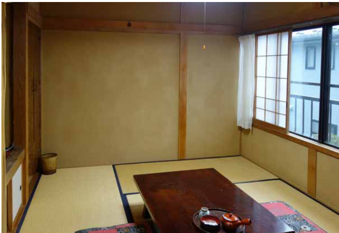
Traditionelle japanske huse har masser af ler i konstruktioner og overflader, idet leret er fremragende til at regulere fugten, så indeklimaet bliver behageligt. Væggene i dette rum har lerpuds i overfladerne, og i gulvene er der lerindskud.
