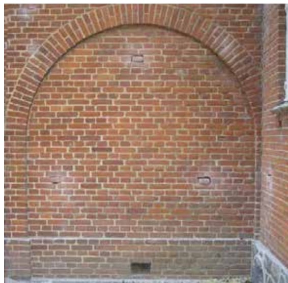
Hulmursisolering – foretages ved forsigtigt at udfræse enkelte mursten på strategiske steder og herefter blæse hulmursisoleringen ind i hulmuren. Efter indblæsningen lukkes hullerne usynligt.
