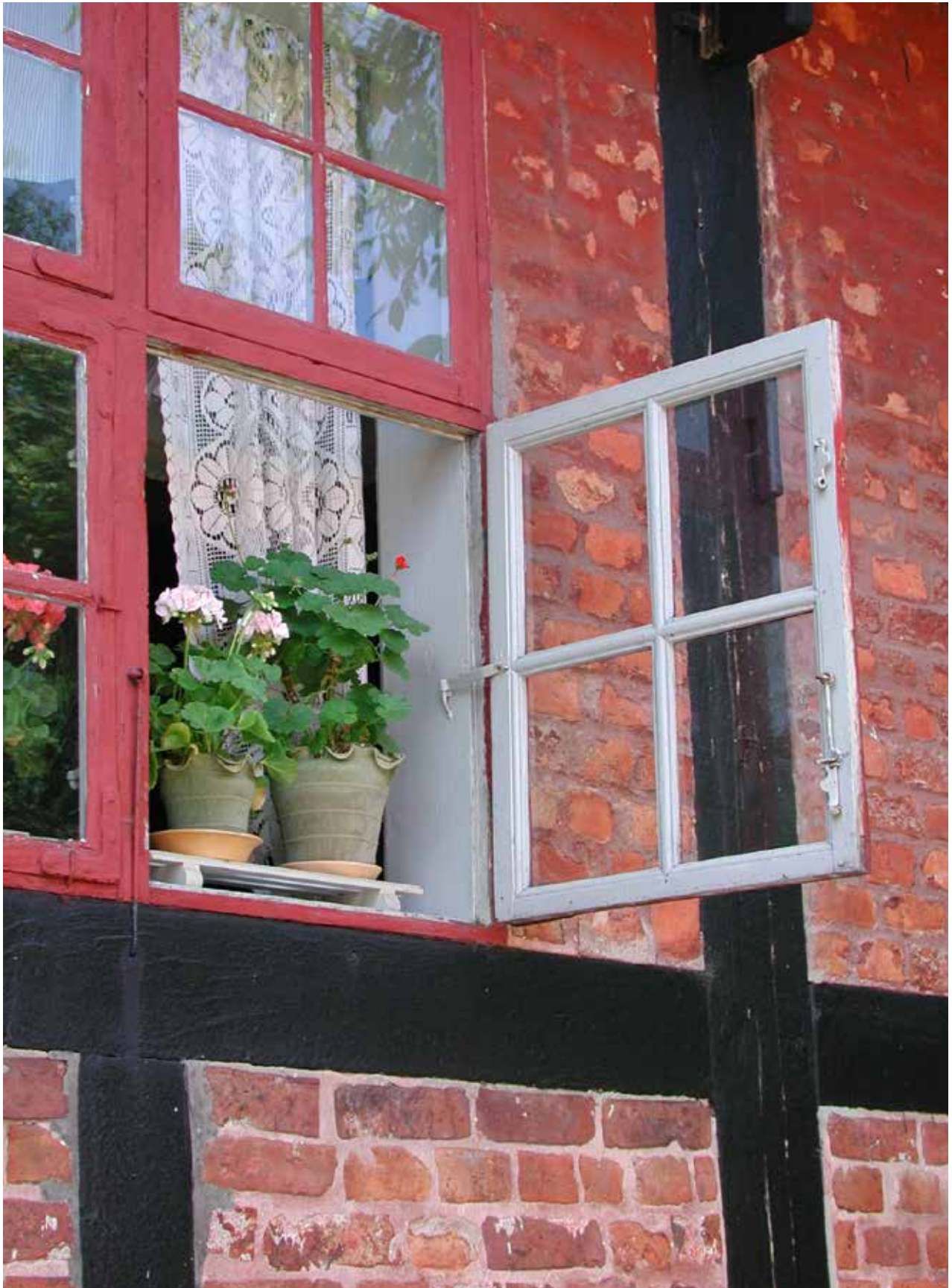
Grønne planter i vinduerne og naturlig udluftning gennem vinduerne går heldigvis aldrig af mode – og kan heller ikke erstattes af diverse moderne apparater og styringssystemer.
