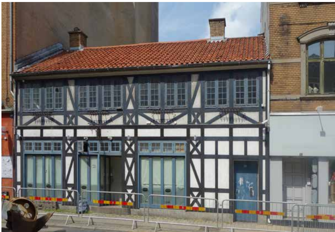
Dette toetages bindingsværkshus i Fredericia ligger nu alene tilbage fra en ældre husrække, mellem nyere femetages bygninger. Det minder derved om, hvordan gaden og byen så ud tidligere.
