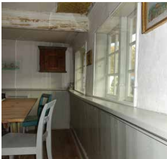
Disse forsatsvinduer sidder helt uden på vindueshullet og tager derfor ikke dagslys.
