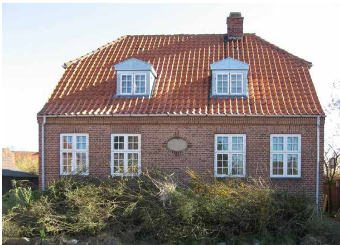
Denne 'Bedre Byggeskik-Villa' i Køge kan, viser konkrete tiltag og supplerende beregninger, energiforbedres, uden at forringe bevaringsværdierne, til Renoveringsklasse 1, efter BR15.
