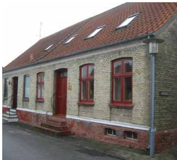
Tilskuddet fra byfornyelsesmidlerne må kun gå til at sikre eller øge bygningens bevaringsværdier. Husejeren til venstre kan bare kikke på den anden ende af huset til højre for at se, hvordan det kan foregå.
