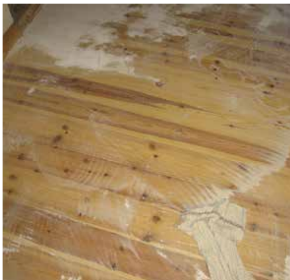
Vask, rengøring og samtidig udluftning er en vigtig del af indeklimaets kvalitet
