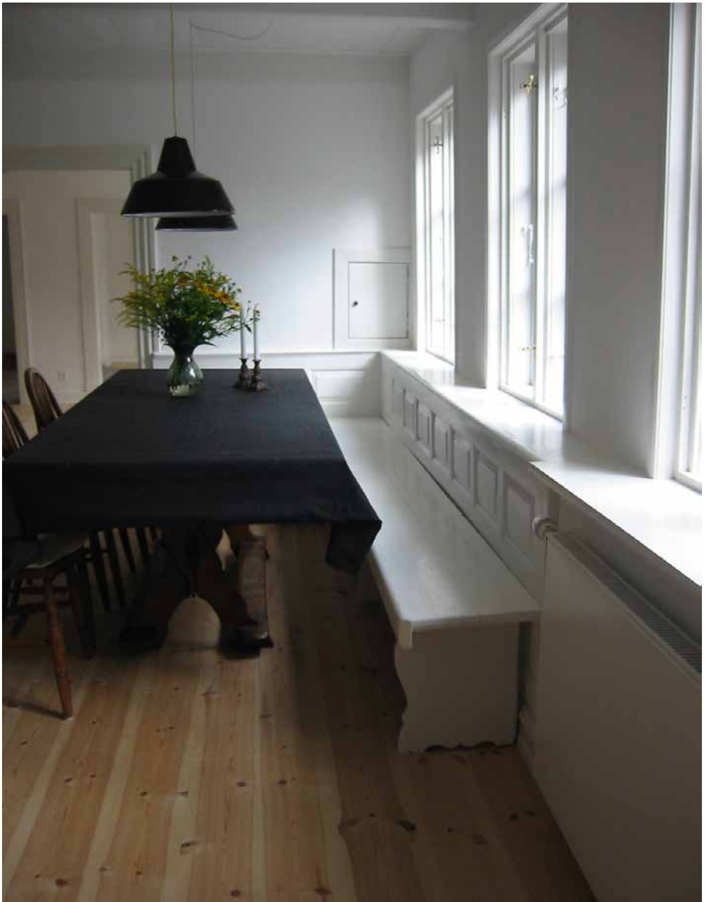
Her er der gjort meget ud af den lave forsatsvæg med fyldingspaneler som de øvrige i rummet – og der er anbragt en bænke med forsatsvæggen som rugstød.
