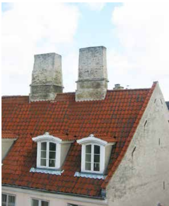
På ældre bygninger er de markante skorstene vigtige for det arkitektoniske udtryk. Men skorstene er også gode til at skabe naturlig ventilation i husene. Så nedlæg dem derfor ikke.
