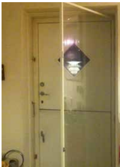
To typer indvendige dobbeltdøre. Den til venstre er isoleret og helt tæt. Den til højre er af hærdet glas, tæt og diskret, men knapt så godt isolerende. Tætheden er dog nok det vigtigste for komforten
