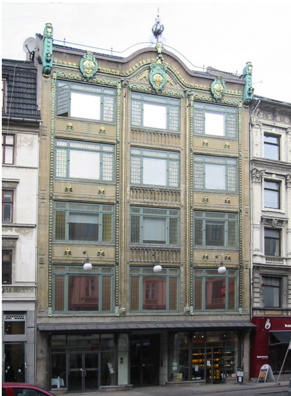
Løvenborgbygningen på Vesterbrogade 34 i København. Opført i 1907 af Anton Rosen. Facaden restaureret og rekonstrueret i 1997 af Raadvad-Centeret v/ arkitekt m.a.a. Søren Vadstrup.
