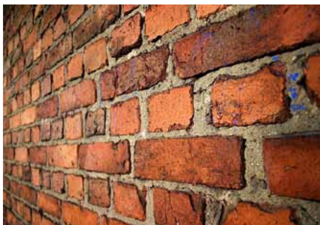
Blank mur - dvs. muren ikke er pudset men fremstår i tegl.
