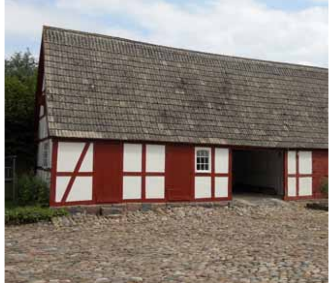
Røde Revledøre og pigstensbelagt gårdsplads.
