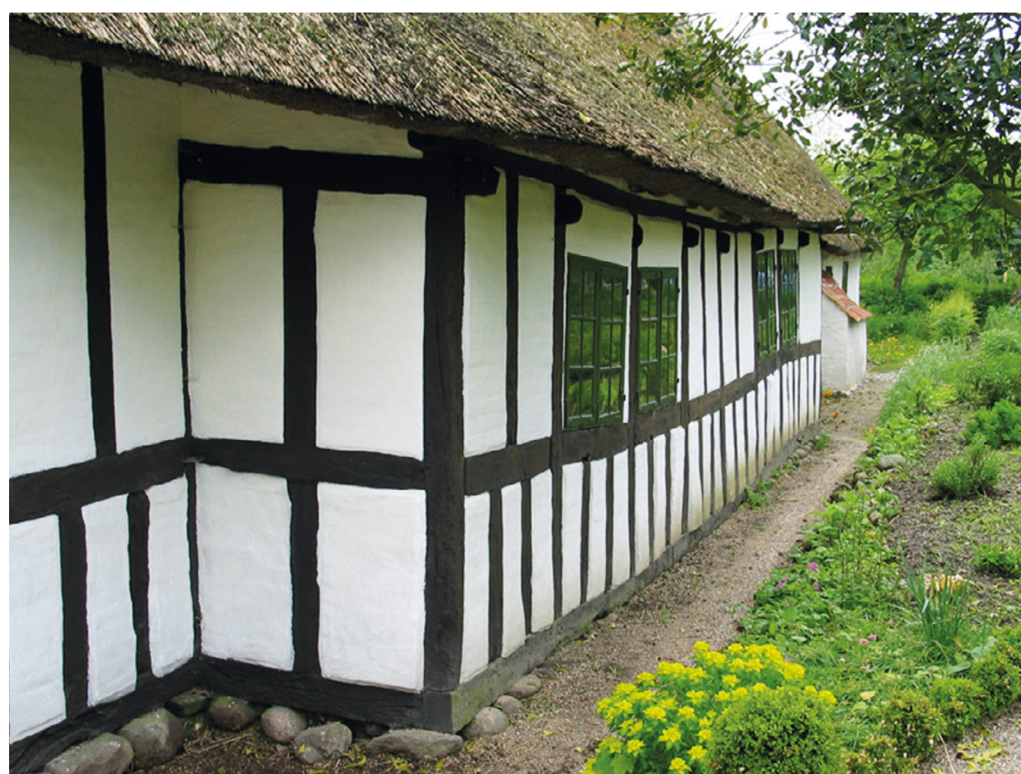
Bindingsværk malet med kalk-kaseintempera.
