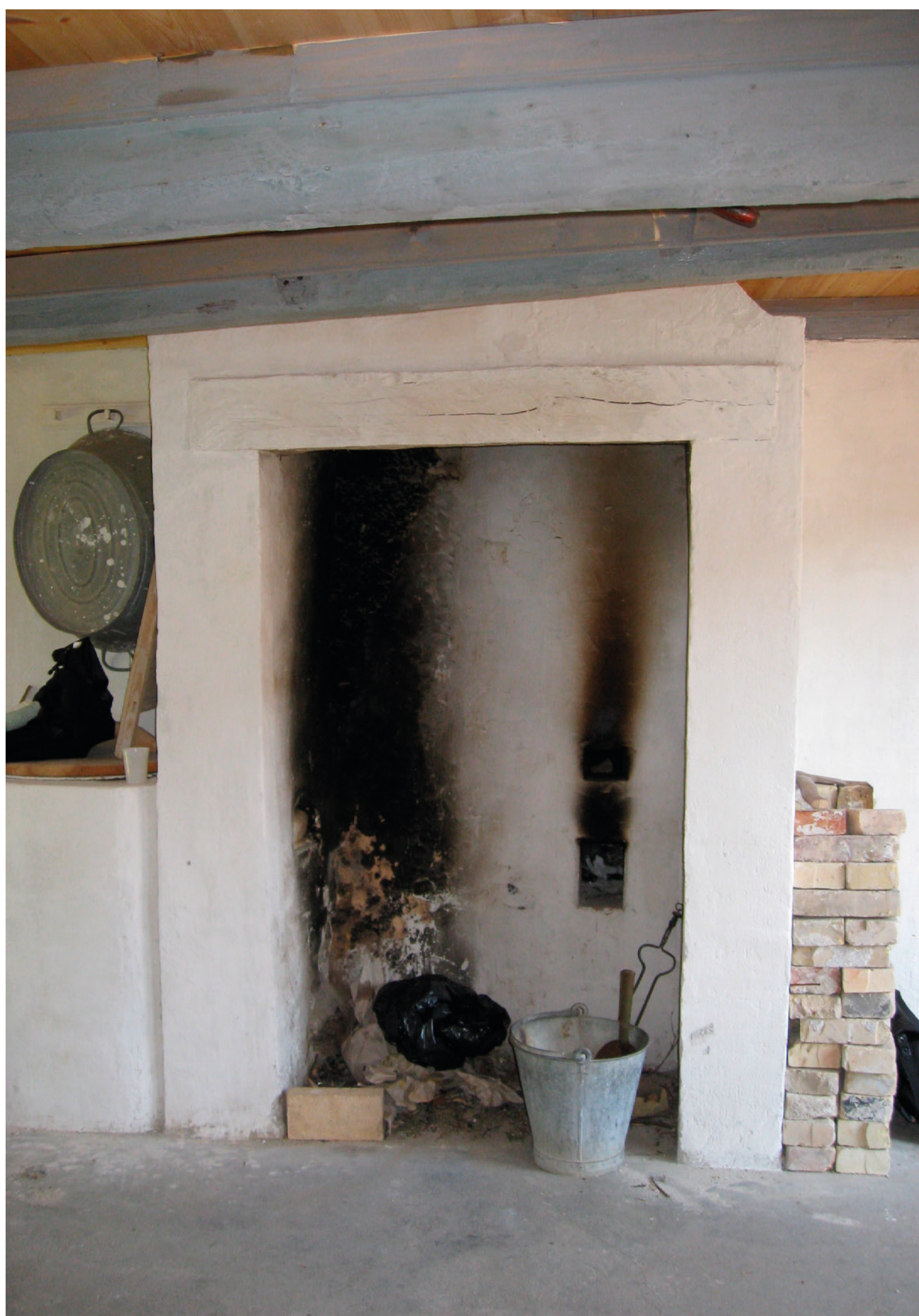
Et ildsteds udseende varierer forholdsvis lidt ud fra et ret fast mønster, så er der spor efter et tidligere ildsted på en eksisterende køkken - eller bryggersskorsten, kan man bygge en rekonstruktion. Her er rekonstruktionen udført uden ildbænke.
