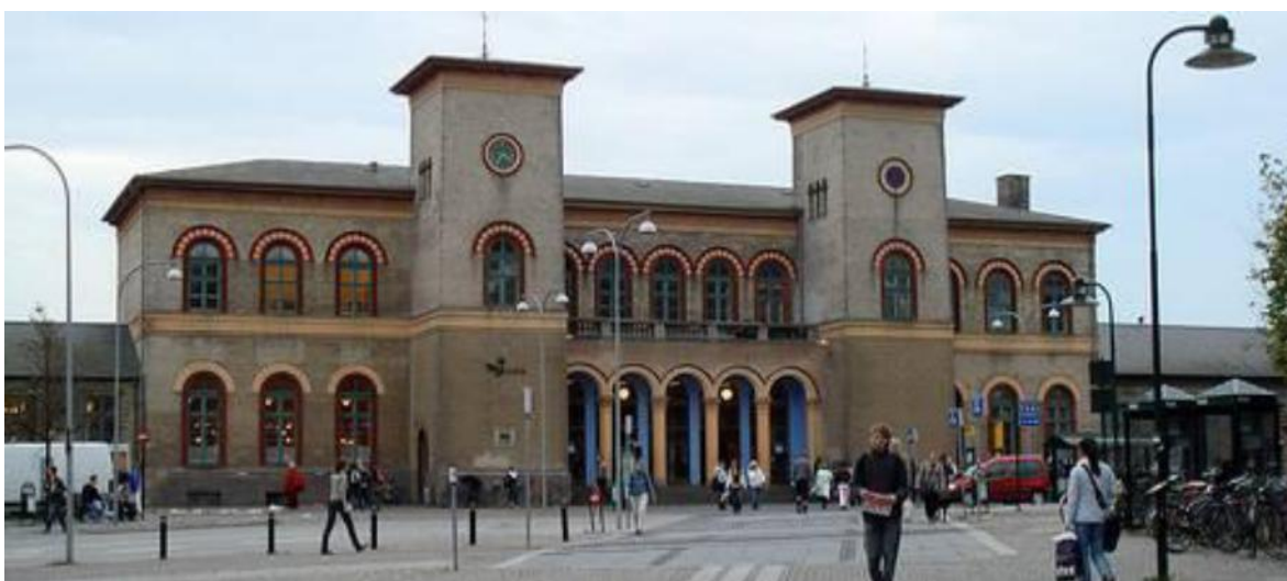
Roskilde Station. De ultramarin, dodenkopf og okkergule facadedekorationer er malet med kalkkaseintempera, for at få de kraftige farver i pigmenterne frem.
