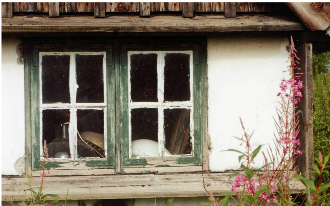
Typisk afskallet plastikmaling – i lange flager
