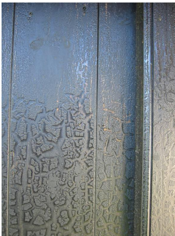
Port malet med sort træbjælefarve. Til venstre nymalet efter 1 år. Til højre overfladen efter 15 år.
