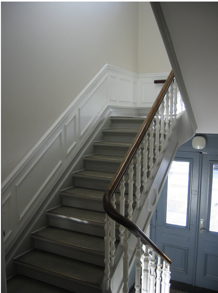
En typisk dansk trappeopgang med en 'indstemt' trætrappe med drejede balustre, profilerede ydervanger og et 'falsk' brystningspanel langs indervæggen. Det 'falske' brystningspanel består af profilerede trælister, opsat direkte på væggen, som topliste, fyldinger og fodpanel, hvorefter 'panelet' er malet, som om det hele var af træ.
